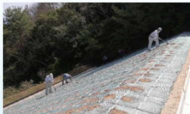
地域性種苗による緑化場所。廿日市市宮島一般廃棄物最終処分場嵩上げに係る整備工事に伴う緑化事業でのり面緑化を行った。(2021年3月25日撮影)
